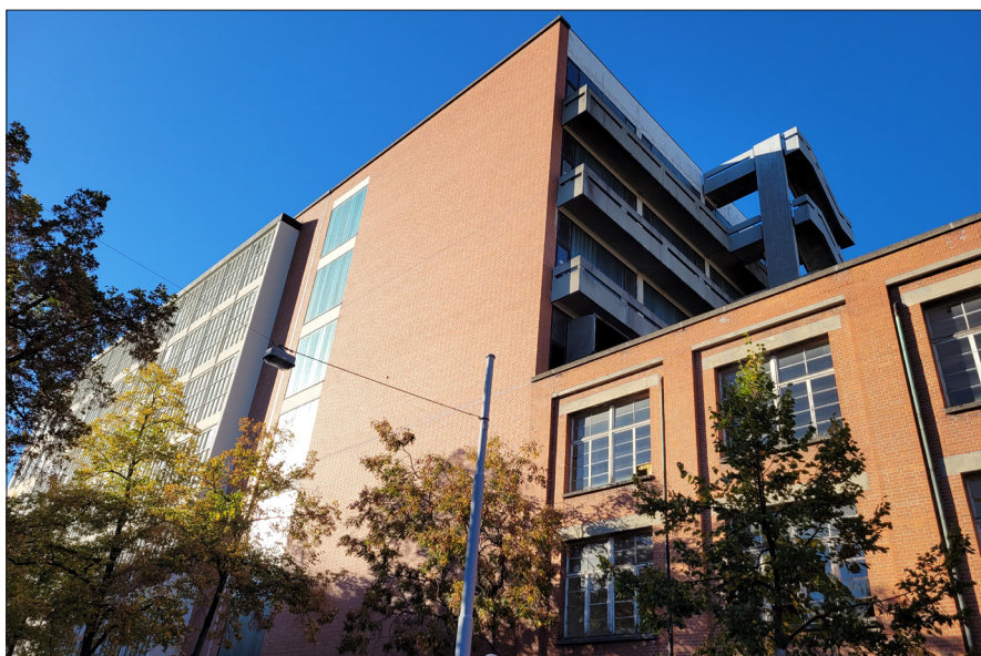
Abb 4: Die Nachkriegsmoderne bei Ciba: die Fabrikhalle WKL 314, die die Ausstellung beherbergt
