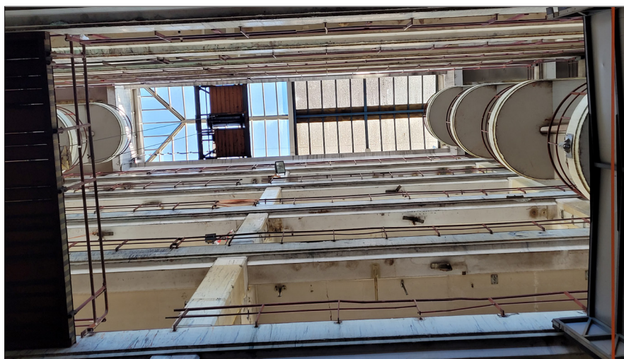
Abb 6: Ein Blick nach oben zeigt die Grösse der Anlage
